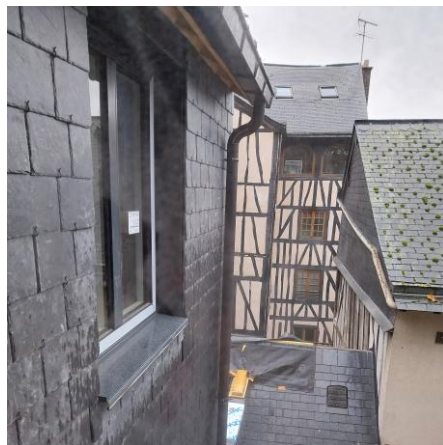
Photos de l'opération après travaux @Métropole Rouen Normandie
