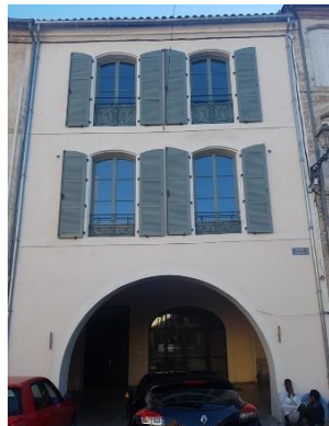
Façade principale avant/après travaux @Ville de Villeneuve-sur-Lot
