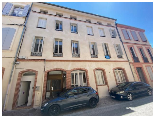
Immeuble après travaux @Ville de Moissac
