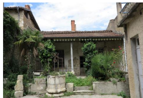
Etat de la façade Sud avant travaux / création d'une véranda @Ville de Lectoure
