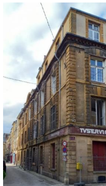
Façade avant travaux @Ville de Sedan
