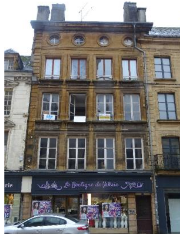
Façade avant travaux @Ville de Sedan
