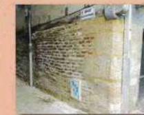
Angle en calcaire coquillier lié à la maçonnerie en brique.
