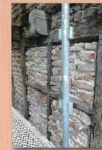
2 e étage, croisée en bois conservée (ajoutée et bouchée).
