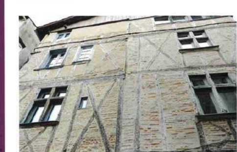
Élévations ouest, étages en pan de bois après restauration.
