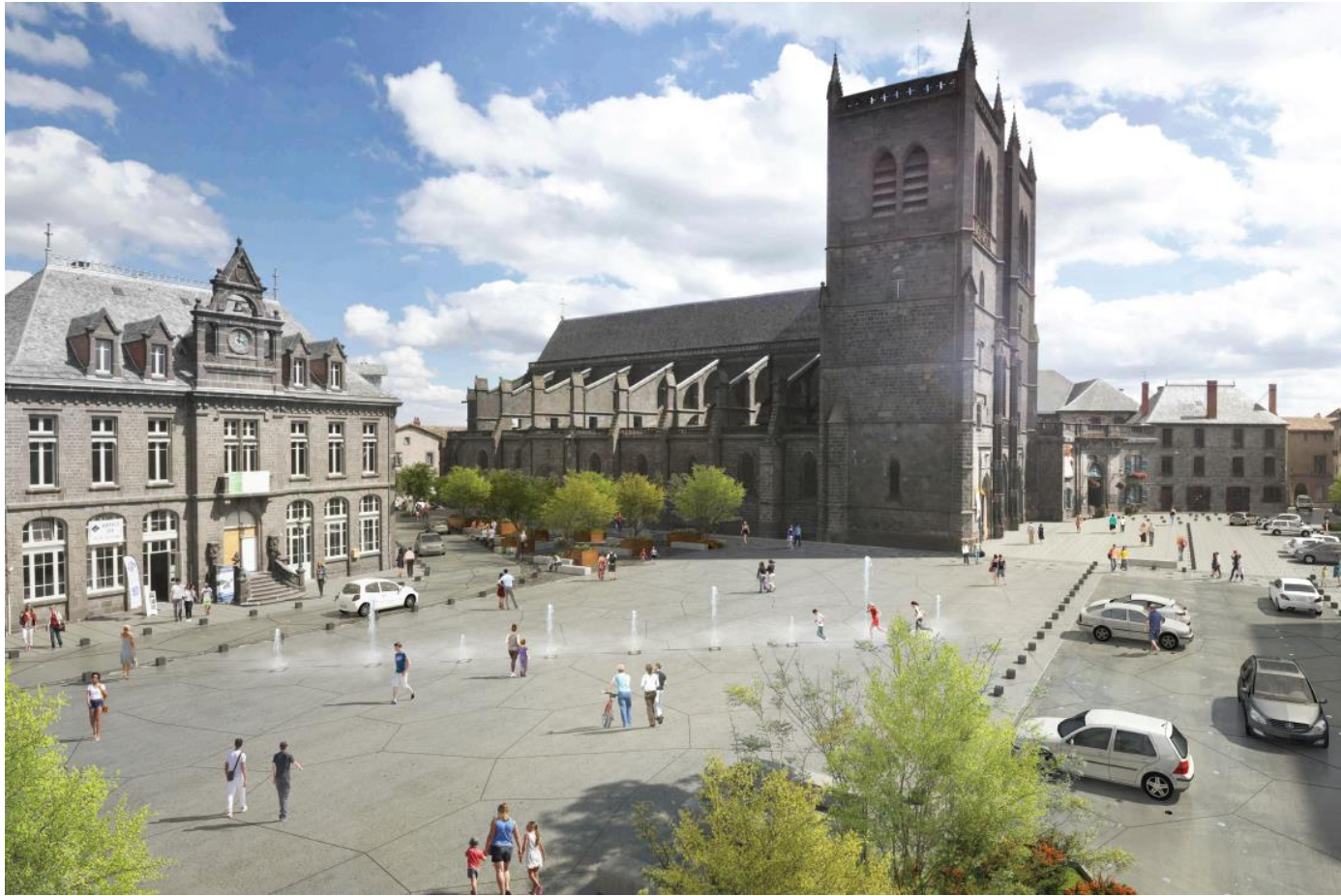
Maison de l'habitat et du patrimoine située dans l'ancien Hôtel de Ville – Caisse d'épargne sur la Place d'Armes de Saint-Flour en cours de chantier
