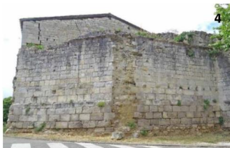
Vestige de l'enceinte urbaine le long de l'église Saint-Felix
