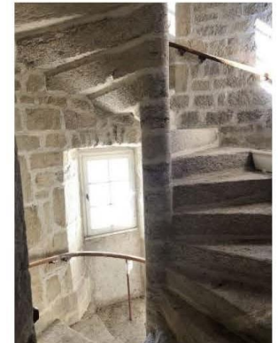
Escalier en vis. Deuxième quart du 16 e siècle ?
