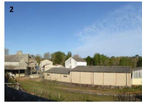
Vue sur la ligne de chemin de fer depuis les hauteurs du boulevard des Rondes
