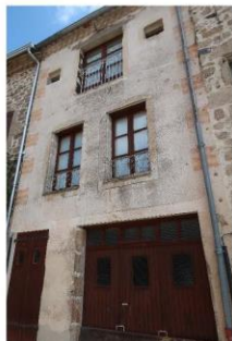
Rue Basse, faubourg de la Soullège. Maison des 15 e -16 e siècles, remaniée au 19 e siècle
