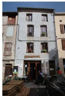
Place de la Halle. Façade de la seconde moitié du 18 e siècle ou du 19 e siècle
