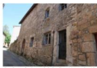
Rue Basse, faubourg de la Soullège. Maison des 15 e -16 e siècles, remaniée au 19 e siècle
