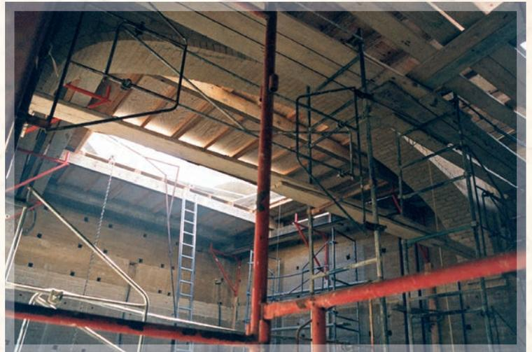
La salle est couverte par un toit à deux pentes, porté par une énorme poutre en lamellé-collé. Une fois le chevronnage installé, nous utilisons pour l'isolation une très ancienne technique balanine: les posidonies.
