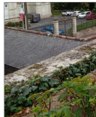
Fig.58 - Présence de lierres en tête de mur et sécurité à la chute inexistante.
