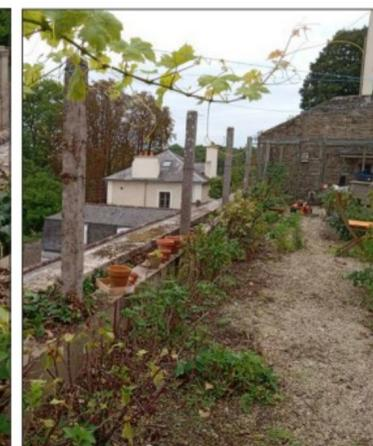
Fig.59 - Clôture en ciment reposant sur une semelle en ciment. En plus de générer un point dur sur le parement extérieur, cet aménagement n'est pas respectueux du monument historique.
