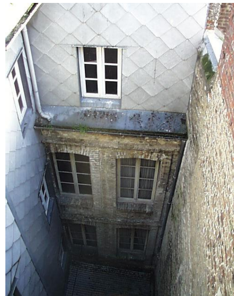
Avant travaux : cour
