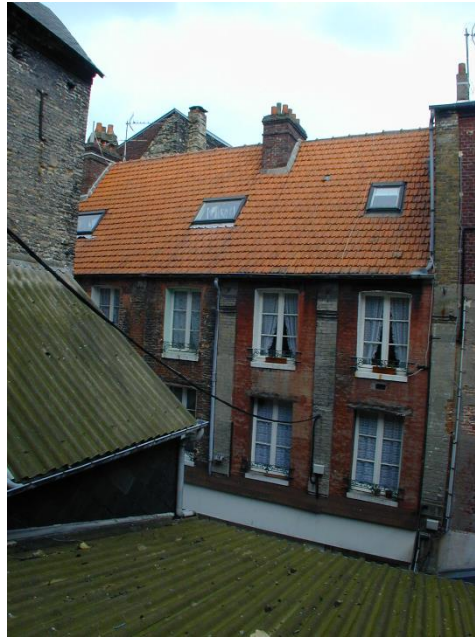
Avant travaux : locaux à démolir partiellement
