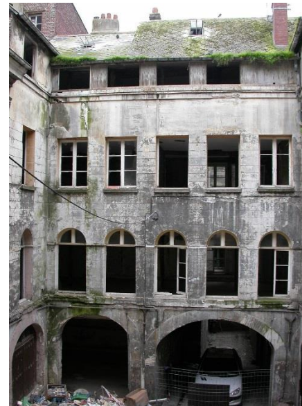
Bâtiment donnant sur rue : avant travaux
