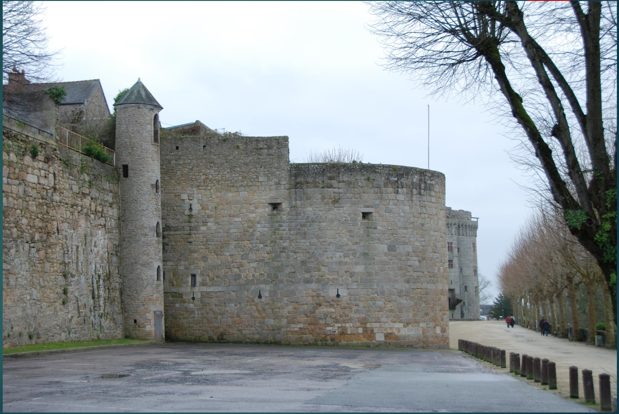
1986 : restauration des parements extérieurs de la tour du Connétable
