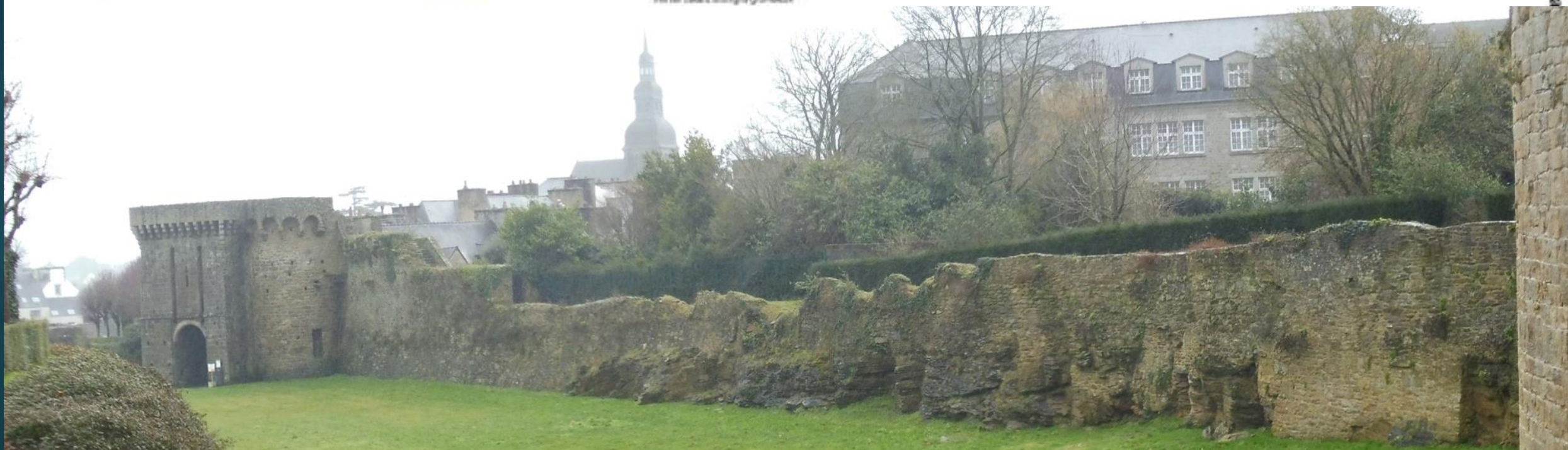
La porte Saint-Malo et la courtine adjacente – état stratigraphique relevée par l'INRAP en juin 2022
