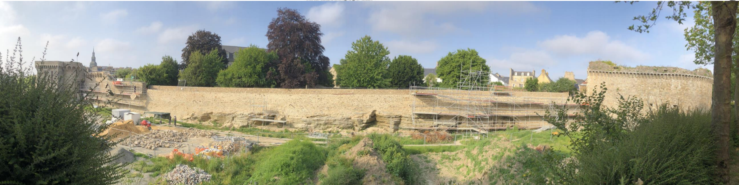
La porte Saint-Malo et la courtine adjacente – état stratigraphique relevée par l’INRAP en juin 2022
