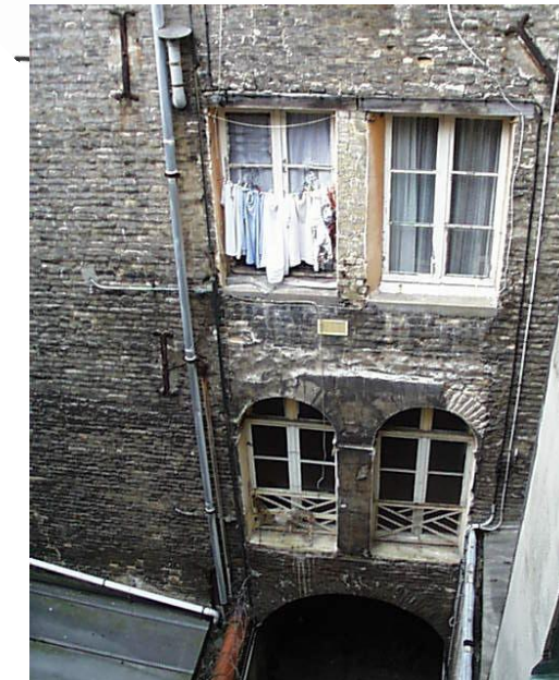
Cour : avant travaux
