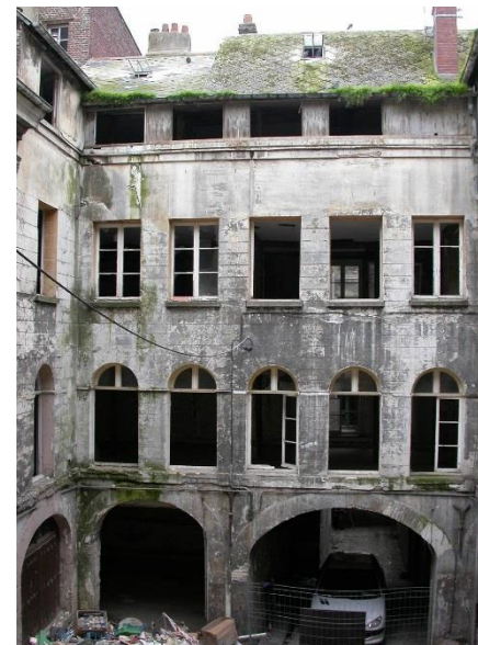
Bâtiment donnant sur rue : avant travaux
