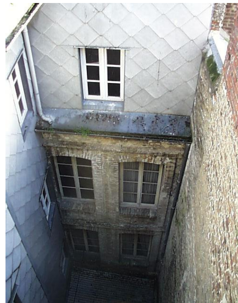
Avant travaux : cour
