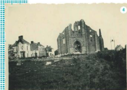
Eglise de l'Immaculée en ruines (vers 1943) Collection particulière Archives de Saint-Nazaire 2013/01/01
