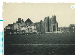
Eglise de l'Immaculée en ruines (vers 1943) Collection particulière Archives de Saint-Nazaire 2013/01/01
