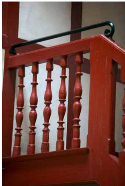
7 Au niveau des escaliers, la circulaire préconise là encore l'application des normes ou le respect d'une hauteur minimale de 0,90 m en rampant, 90 cm sont nécessaires - sur palier, le mètre doit être assuré © Isabelle Joly
