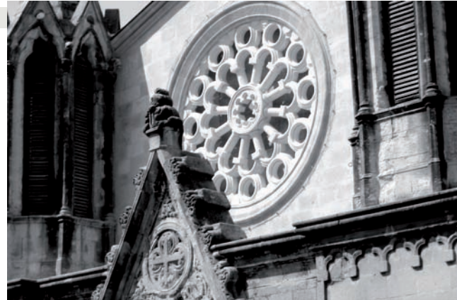
La rosace de l'église Saint-Pons après sa rénovation.
