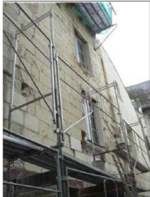
Doc 14 Exemple de suivi de chantier © Séverine Bochereau-Jeanneau
