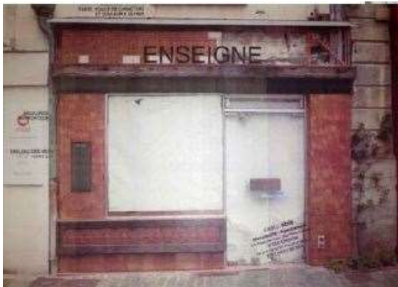
Doc 12 Exemple d’accompagnement d’un projet Vue avant travaux © Séverine Bochereau-Jeanneau
