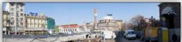
Travaux du métro @ Svobodna VRANTCHEVA
