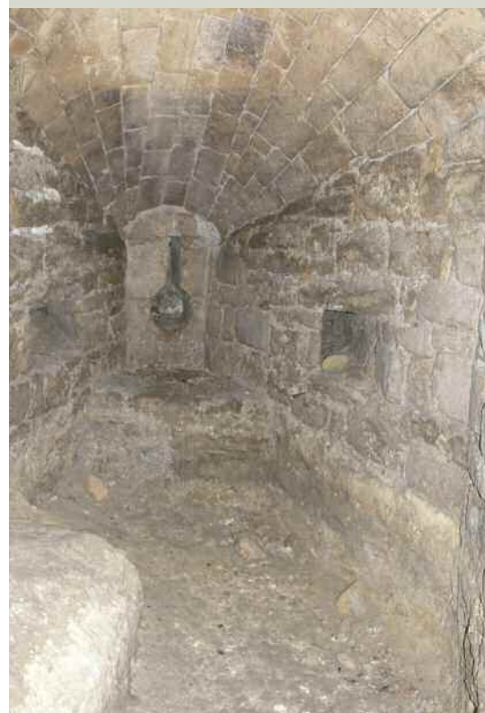
Un des postes de tir à archère canonnière de la galerie de la Porte d'Ennery toujours visible servait à défendre l'entrée de la ville.
