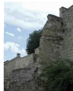
Vestiges de la tour du Pas-d'Âne au niveau du boulevard Jean-Jaurès.
