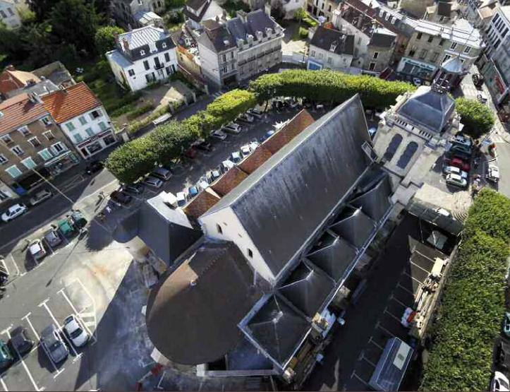
Photo aérienne de l'église au cours de la restauration en septembre 2009. © Philippe Lhomel
