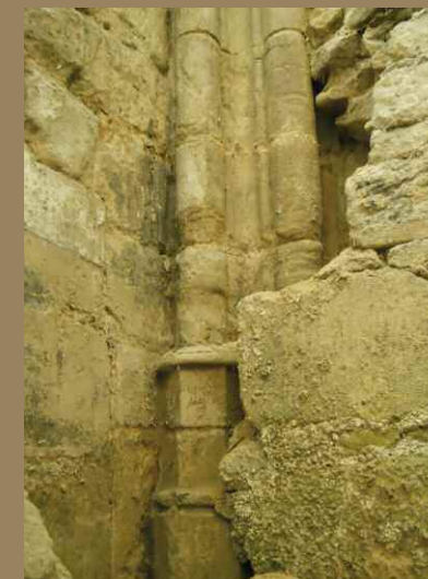
Seul vestige de la Basilique détruite en 1589, une colonne de la nef engagée dans la maçonnerie actuelle (non visible par le public).
