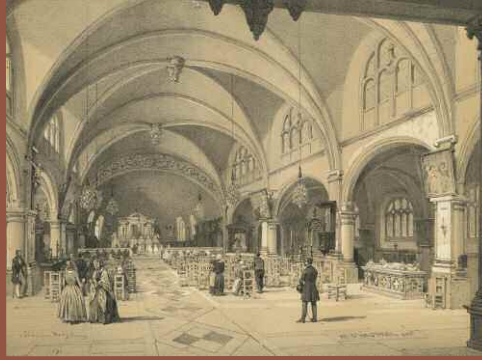
A l'intérieur, les colonnes reçoivent les ogives de la voûte par le biais de pilastres ioniques. Les voûtes de la nef sont réalisées en bois recouvert de plâtre. Au centre des quatre travées les clés de voûte réalisées en 1843 sont pendantes. Vue de l'intérieur, gravure d'Adolphe d'Hastrel - milieu du XIX ème siècle.
