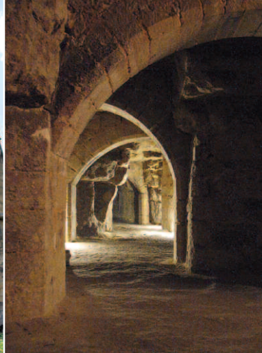
La partie haute de la cave des Moineaux est voûtée en croisée d'ogive. Les niveaux inférieurs abritent des anciennes carrières creusées entre le XIII ème et le XV ème siècles. Le cœur historique de Pontoise concentre de très nombreuses carrières souterraines.
