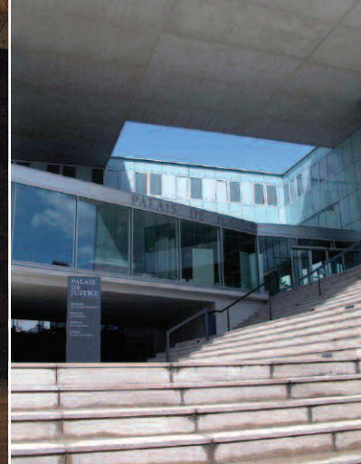
Le Palais de Justice de Pontoise réunit quatre tribunaux sur un même site. L'architecte a su l'adapter aux contraintes du terrain et mettre en valeur différents matériaux : béton, pierres, verre...
