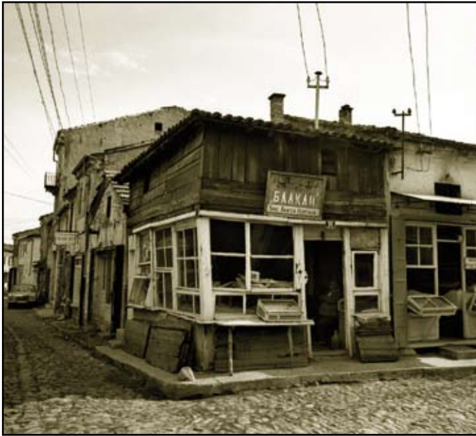
Дуќан (крај XIX - почеток XX век) бондручна конструкција Echoppe (XIX ème siècle), ossature en bois
