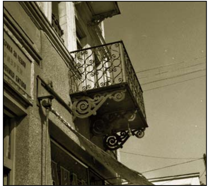
Балкони со ограда од ковано железо, ослонети на конзоли од лиено железо (крај XIX / почеток XX век) - Стара битолска чаршија Balcons avec grille en fer forgé, posés sur des consoles en fonte (fin XIX ème - début XX ème siècle)
