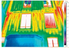
Effet de paroi froide sur un mur en pans de bois et moellons et thermographie infra-rouge de façade.
