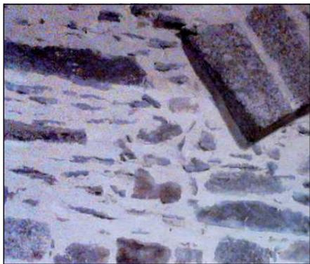
**Figure 1/4.b** - Mur gneiss dé-jointé
